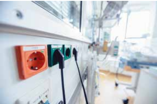
Verschiedenfarbige Steckdosenleiste in den Behandlungsräumen: Die rot/orangen Steckdosen sind vorrangig für lebenswichtige Maschinen.
